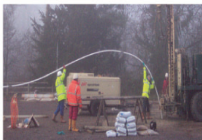
该系统用于监测地下水氯代烷含量变化（英国 Waterra）
